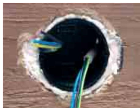
fixovanie rozvodnej krabice na drevenom hranole
