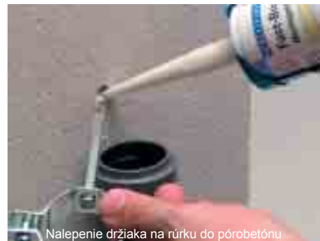
Nalepenie držiaka na rúčku do pórobetónu
