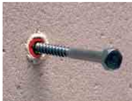
fixovanie plastovej hmoždenky do pórobetónu
