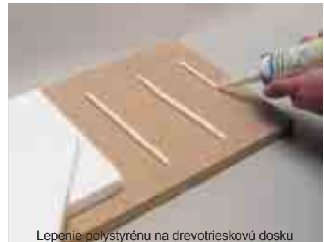
Lepenie polystyrénu na drevotrieskovú dosku
