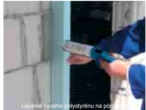
Lepenie tvrdého polystyrénu na pórobetón
