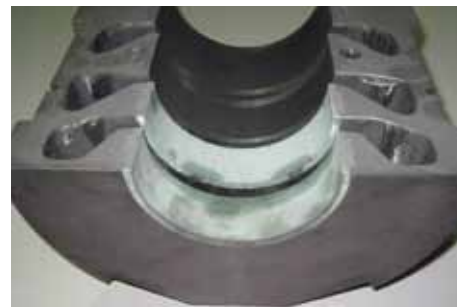
Oprava tesniacích plôch v bloku labyrintového tesnenia
